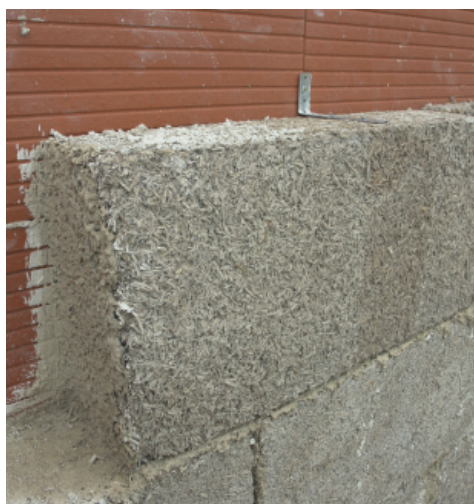
Assemblage au mortier des briques de chanvre.
