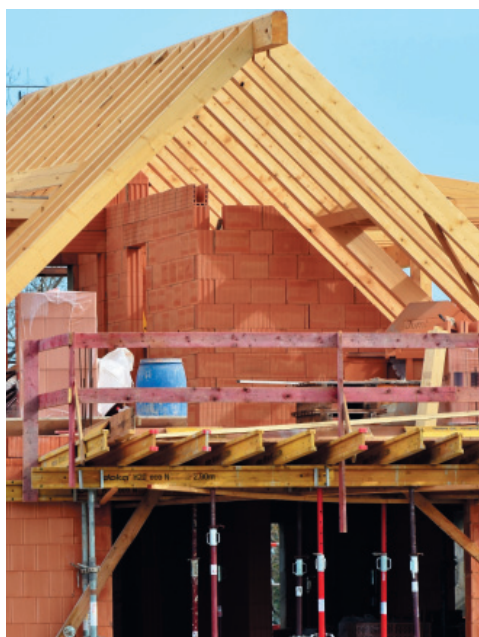
Une construction neuve permet des choix techniques innovants.
