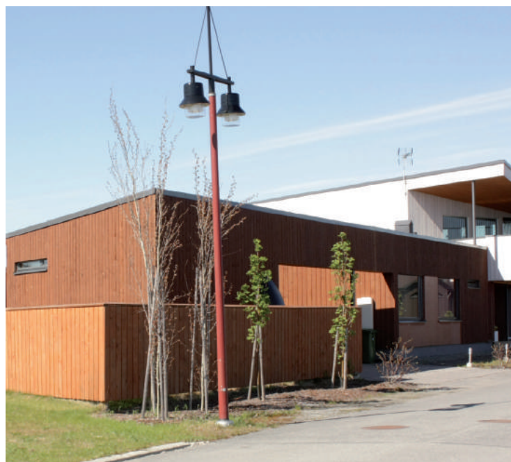
Les modules disjoints permettent un meilleur comportement acoustique mais favorisent les déperditions de chaleur.
