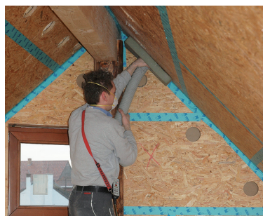
Moyennant une pose ajustée, des panneaux d'OSB* peuvent remplacer la membrane pare-air* et frein de vapeur tout en assurant le contreventement. Mais l'insufflation derrière des panneaux opaques suppose un bon repérage des éléments d'ossature pour s'assurer que tous les espaces seront parfaitement remplis. Photo Y. Dewael.
