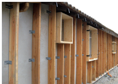
1. Fixation des montants bois et des précadres des menuiseries sur la façade avec platines métalliques.
