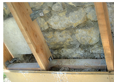
2-3. Pose des panneaux pare-pluie* et remplissage d'un conglomérat léger à base de roseaux.
