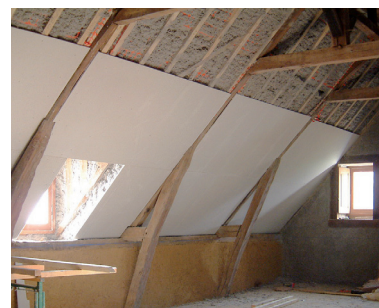
On peut également procéder par projection de cellulose humide. Dans ce cas la pose des plafonds doit n'être effectuée qu'après un parfait séchage de la matière. Doc. Entreprise S.Tinel, in La Maison écologique , n° 51.
