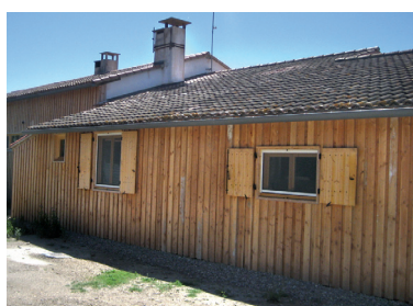
5. Paroi finie en lames de douglas posées verticalement pour améliorer le drainage et la durabilité.
