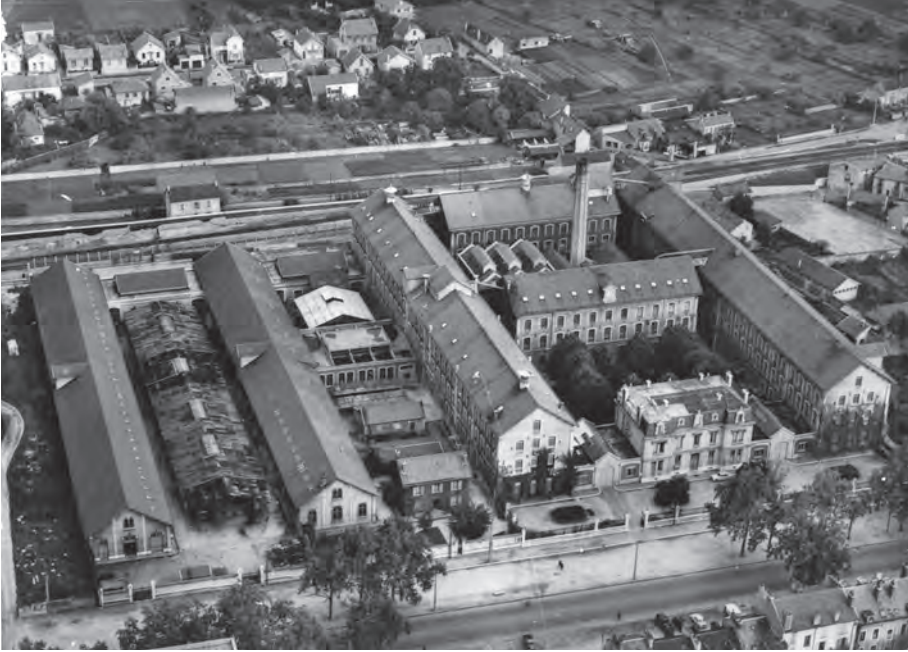
Fig. 9 – La manufacture de Dijon, boulevard Voltaire, bâtiments construits vers 1881, démolis en 1976 ; vue aérienne en carte postale, années 1950.
