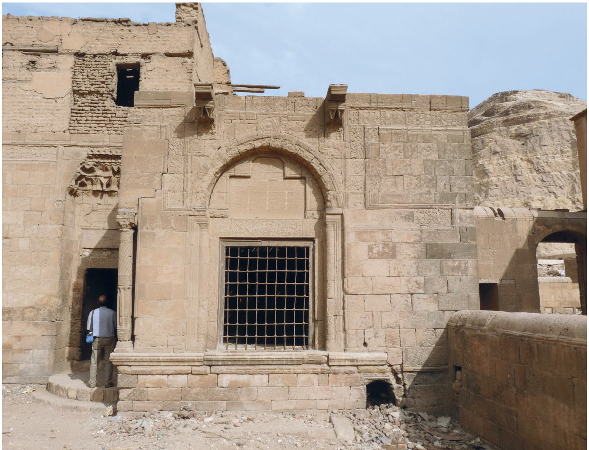
Fig. 44. Façade ouest du sabil.
