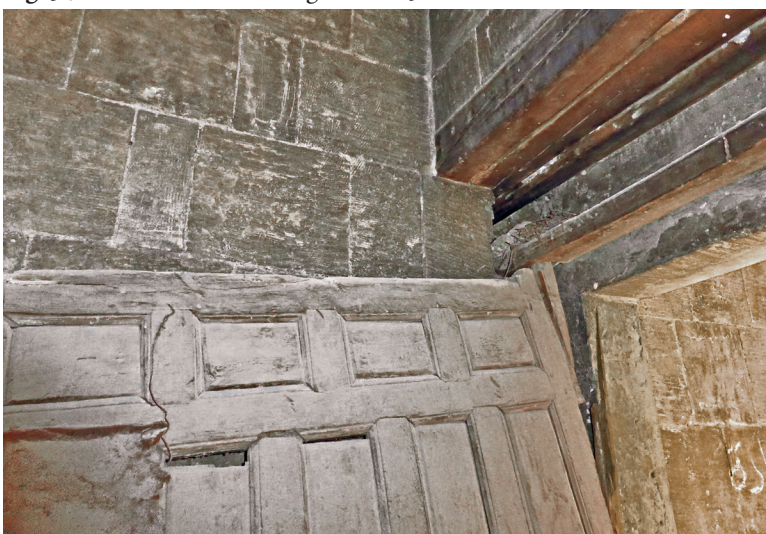
Fig. 35. Porte d'entrée du logement A3 vue de la cage d'escalier.
