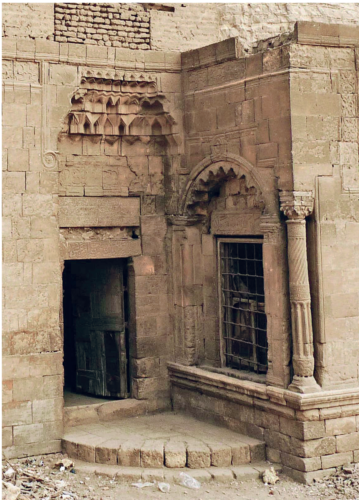
Fig. 29. Porte d'entrée du bâtiment A.
