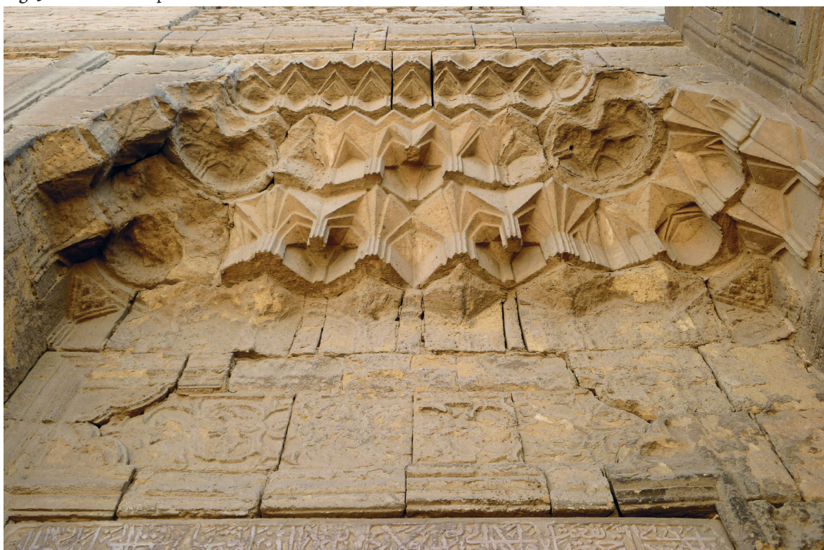
Fig. 31. La voûte vue de dessous.
