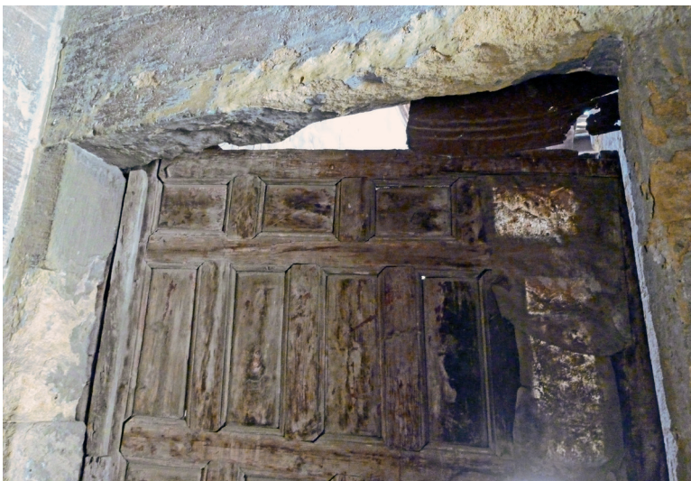
Fig. 34. Porte d'entrée du logement A3 vue du corridor.
