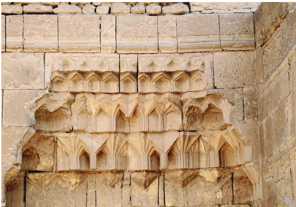
Fig. 30. Voûte de la porte d'entrée vue de face.
