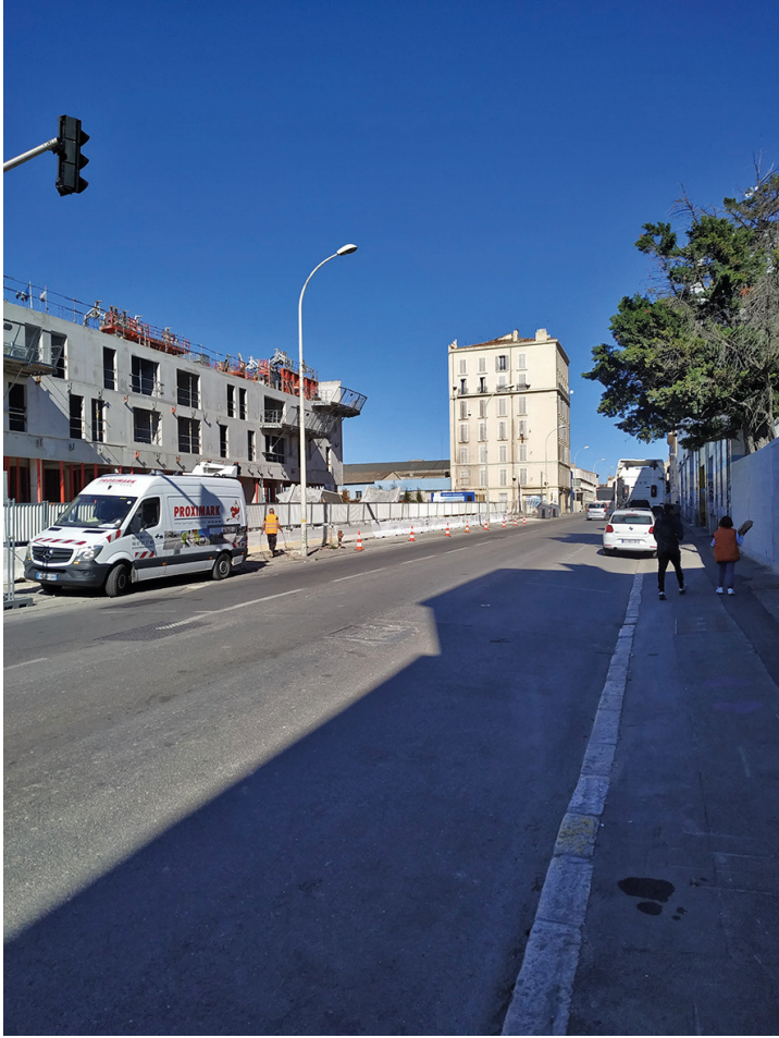
Figure 2. « Quand l'ancienne ville et la nouvelle se font face », photo prise rue de Lyon, village des Crottes, montrant un ancien immeuble qui demeure encerclé par de nouvelles constructions © photo de l'auteur.
